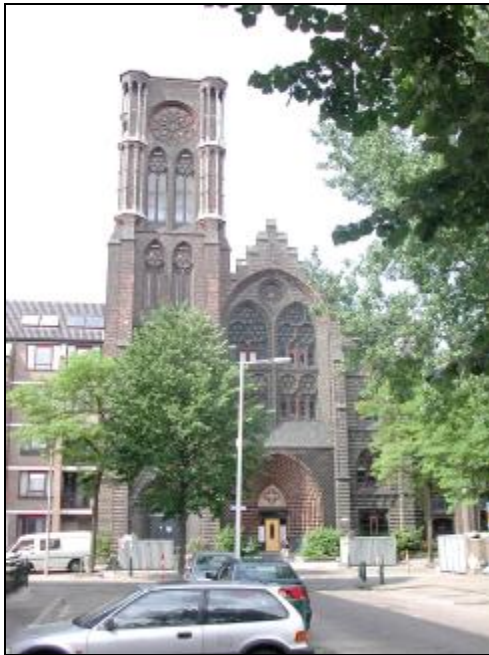
Voormalige kerk aan de Goudse Rijweg
